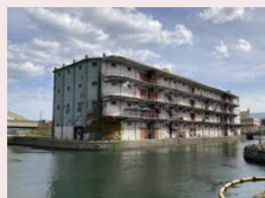
北海製罐第3倉庫
