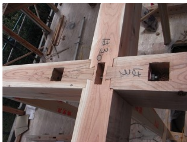
引きボルト接合による仕口
