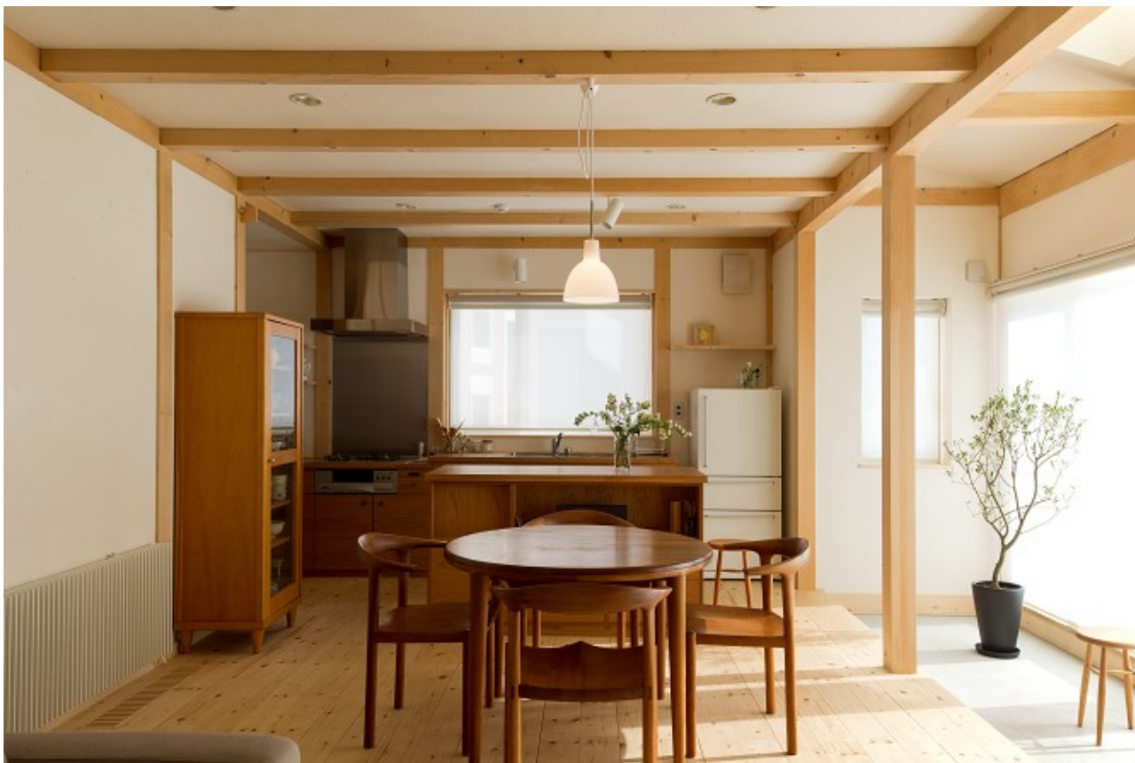
室内側を真壁として仕上げ、構造材が見える造りとして
