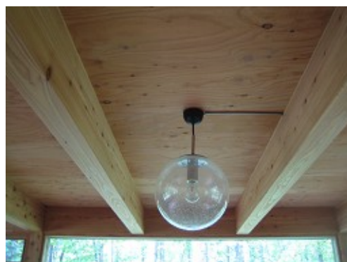
道産カラマツの構造用合板と床梁の天井仕上げ
