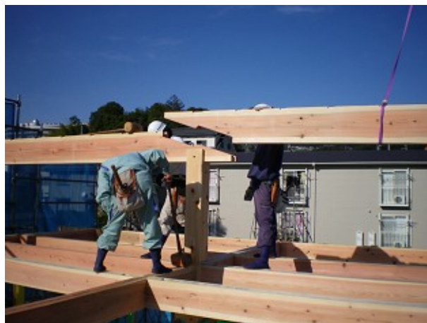
横架材接合部のみ手刻みとしている軸組の施工
