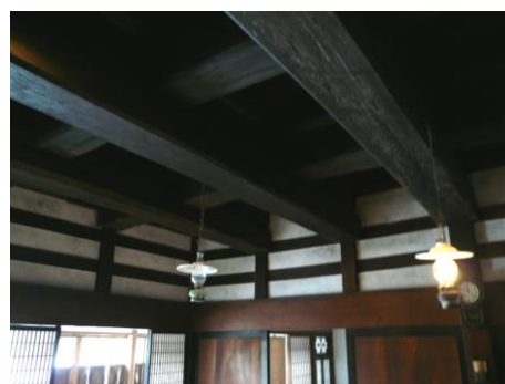
旧樋口家住宅（北海道開拓の村） 富山県特有のワクノウチ構法
