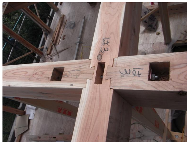
引きボルト接合による仕口
