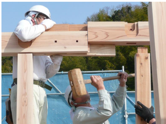
プレカット機械と手刻みの併用
