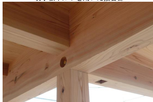
引きボルトを用いた接合部
