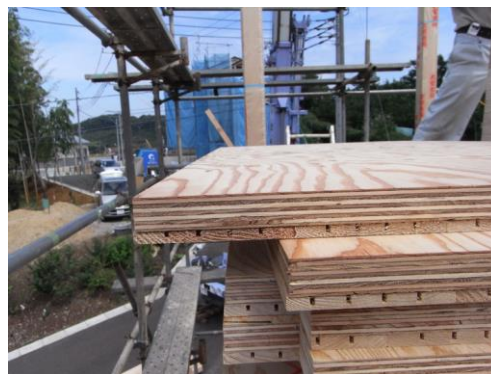
構造用合板24mmにスギ9mmを貼った仕上げ
