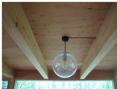
道産カラマツの構造用合板と床梁の天井仕上げ
