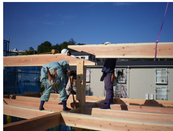
横架材接合部のみ手刻みとしている軸組の施工
