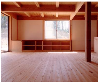
真壁形式の骨太な加工
