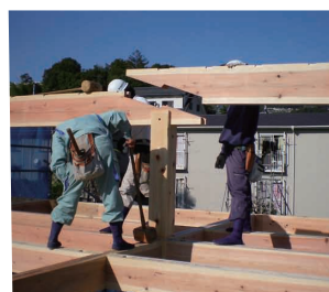
大工の技と木組み(横架材接合部を手刻みとした軸組の施工)
