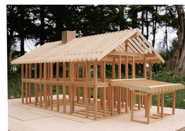
骨太・長寿命の木造軸組 (北の民家コンセプト模型)
